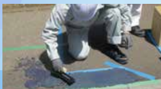
STEP5 敷き均し
