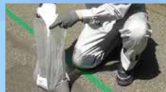
STEP2 骨材袋に樹脂を投入
